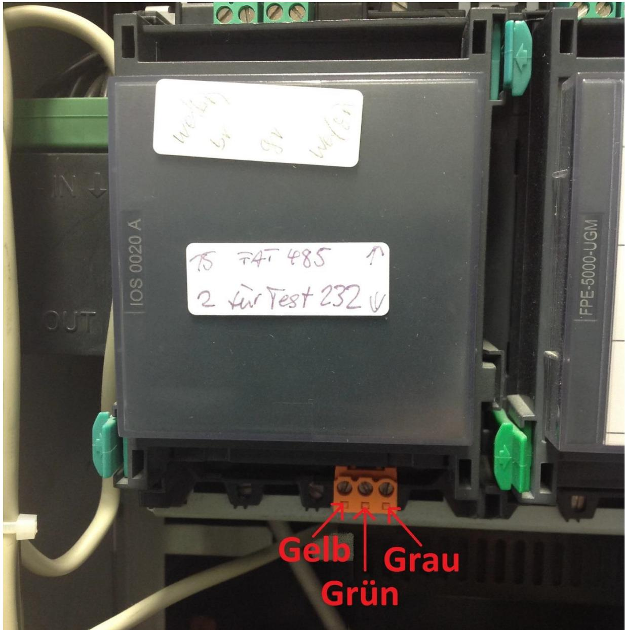
Die Schnittstelle kann zwischen FAT und Drucker umgeschaltet werden, für die Wartungsbox wird die Einstellung Drucker benötigt.
